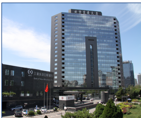
三井化学（中国）管理有限公司北京分公司 所入住的北京发展大厦
